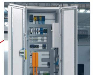
Die Steuerelektronik, Sicherheitstechnik und der Industrie-PC sind im **Schaltschrank** verbaut.
